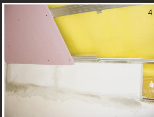
4. PŁYTE PRZYKRECAMY NAJPIERW DO CD 60 A NA KONCU DO PROFILU-V
