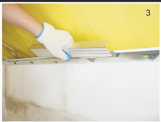
3. ZAGIĘTY CD 60 WKLIKUJEMY EWENTUALNIE W MIEJSCE ŁĄCZENIA PŁYT LUB STOSUJEMY JAKO ŁĄCZNIK WZDŁUŻNY PROFILI-V
